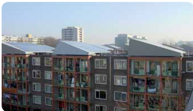
Жилой дом 2 Megawatt Project, Голландия
